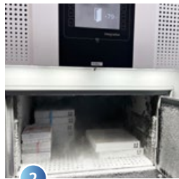
2 Lagerung in Ultratiefkühlkühlern bei -70 °C bis -80 °C
